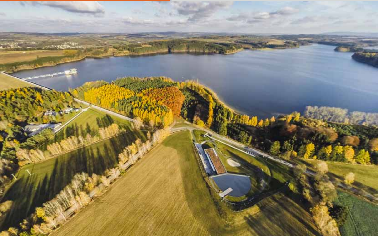
▲ Pohled na návštěvnícké středisko Vodní dům u nádrže Švihov (foto: Tomáš Malý)
