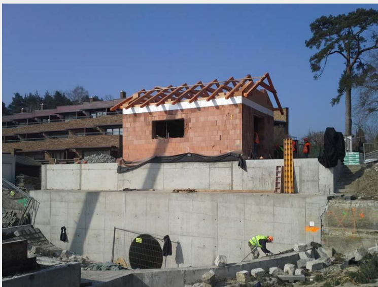
▼ Výstavba technologického domku
