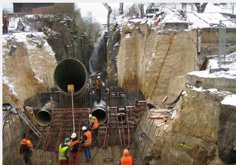
▼ Armovací práce – pohled na spodní výpustě a odpadní potrubí DN1500 pro bezpečnostní přeliv
