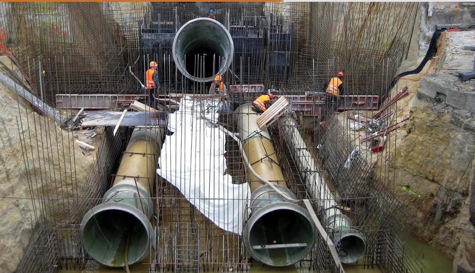
▲ Základové výpustě odběrného objektu Máchova jezera
