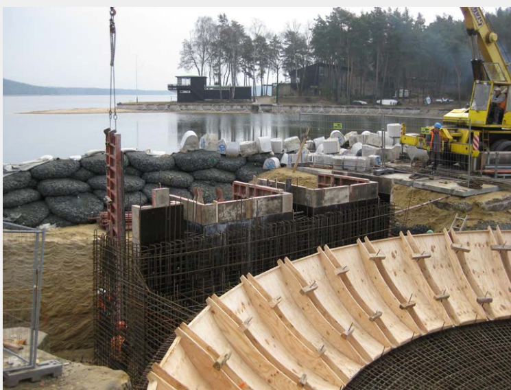
▲ Armovací práce – kašnový přeliv a vtokové objekty spodních výpustí
