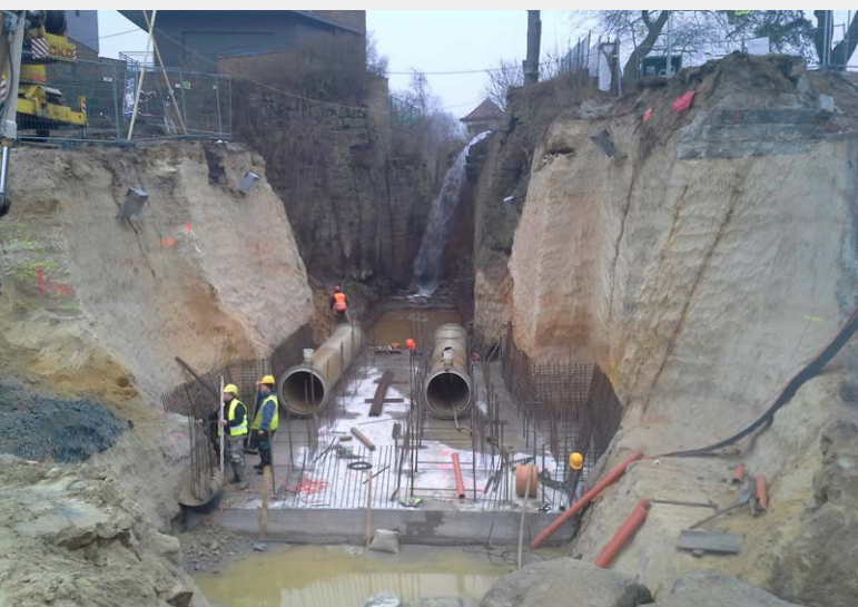
▼ Dokončení betonáže spodní desky a položení dvou spodních výpustí DN1000 ze sklolaminátu
