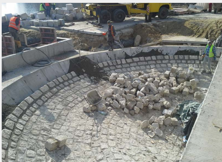
▲ Kamenické práce – kašnový přeliv
