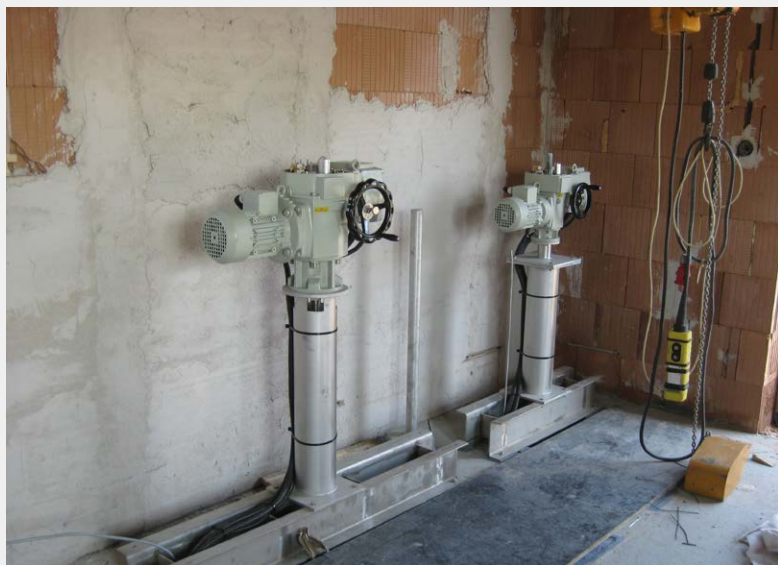
▼ Výstavba technologického domku – ovládací stojany stavidlových uzávěrů
