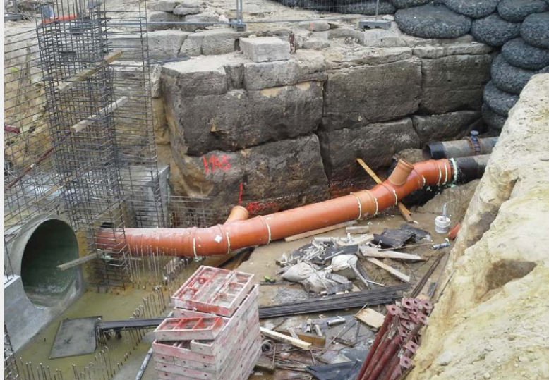
▲ Převod vody (MZP) při dobetonování spodní výpusti DN500
