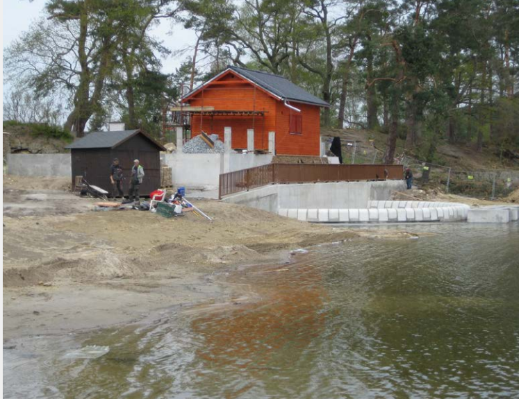
▲ Návodní strana – dokončovací práce
