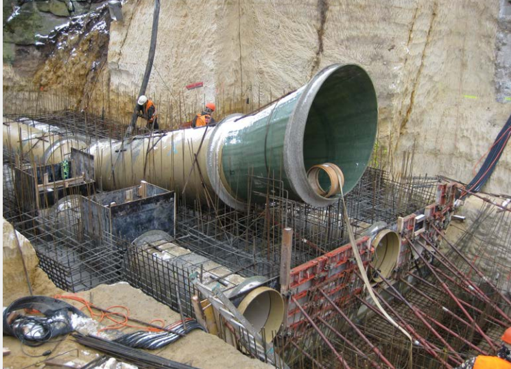
▲ Armovací práce – pohled na potrubí, lze vidět přípravu otvorů pro uzávěry
