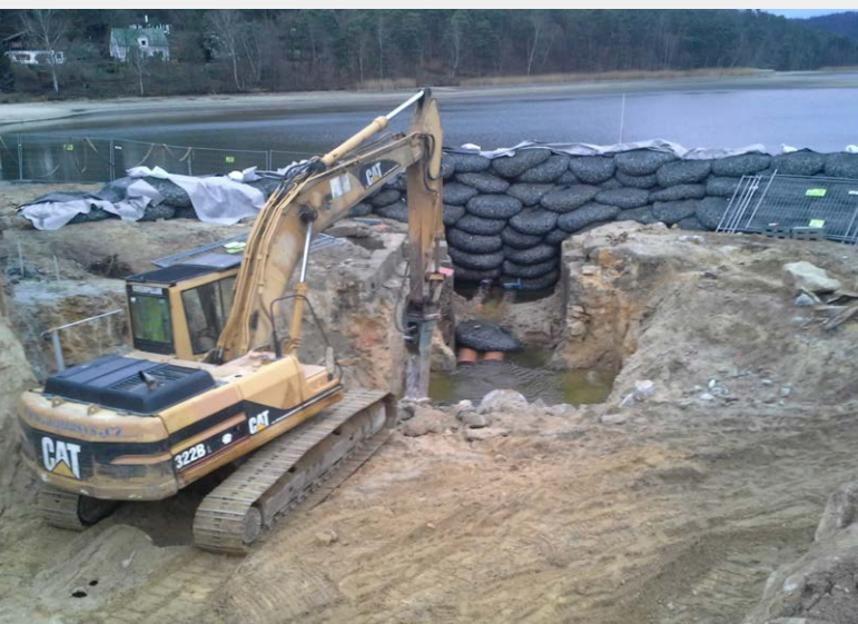
▲ Pohled na provizorní hráz – dvě spodní výpustě DN500 pro MZP
