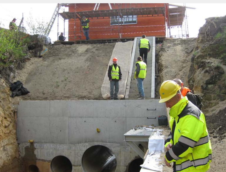
▼ Vzdušná strana – dokončovací práce
