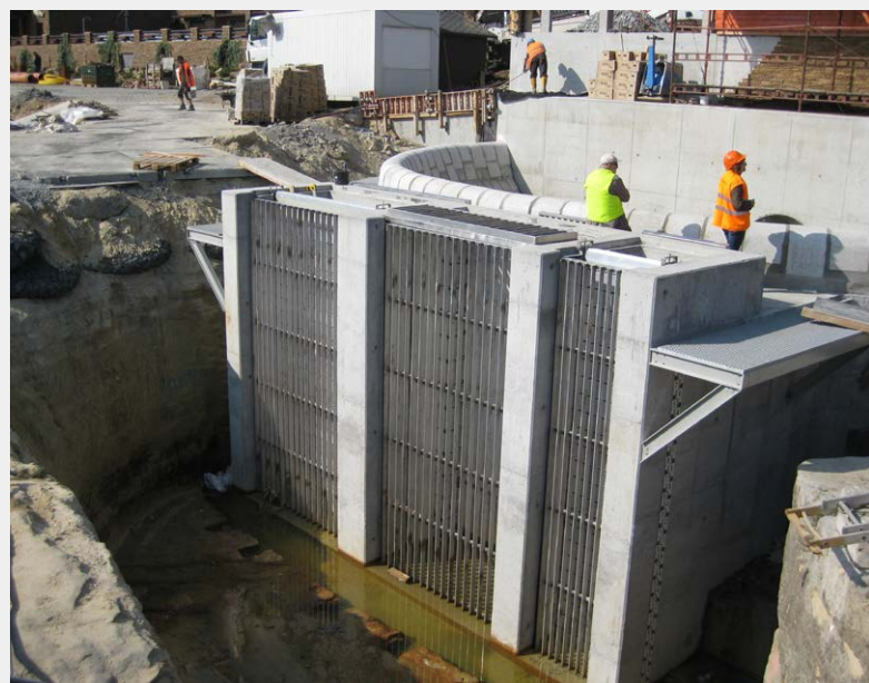
▲ Vtokové objekty spodních výpustí – dokončení
